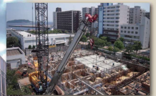
建設中の新講堂
